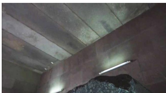
Les poutres du plafond de la Chambre du Roi portent encore les traces laissées par la sève des cales en cèdre sur lesquelles elles étaient posées pour leur transport. Les premières livrées sont les plus marquées.
