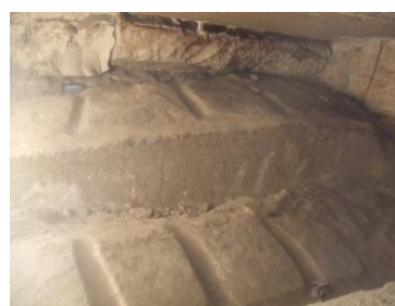
Sur la face supérieure des poutres beaucoup plus hautes que large, des engravures d'arrimage ont été creusées pour assurer la stabilité de l'ensemble.
