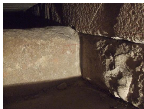
Avant livraison, les carriers avaient préalablement tracé l'axe central et les repères latéraux sur chaque poutres pour leur mise en place qui était réalisée par le côté Est de la Chambre du Roi.
