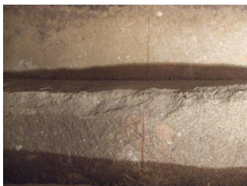
Avant livraison, les carriers avaient préalablement tracé l'axe central et les repères latéraux sur chaque poutres pour leur mise en place qui était réalisée par le côté Est de la Chambre du Roi.
